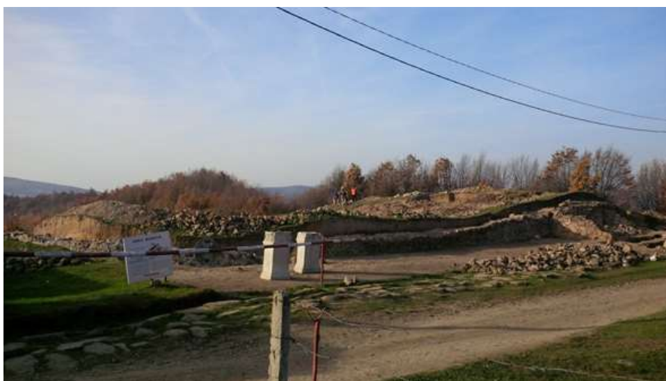
Fig. 1 - Roman building (customs or burgus ) from Porolissum, second phase wall construction, east side (Photo: E.E. Sabo, 2014) Edificiu roman (vamă sau burgus ) de la Porolissum, construcția de zid din faza a doua, latura estică (Foto: E.E. Sabo, 2014)
