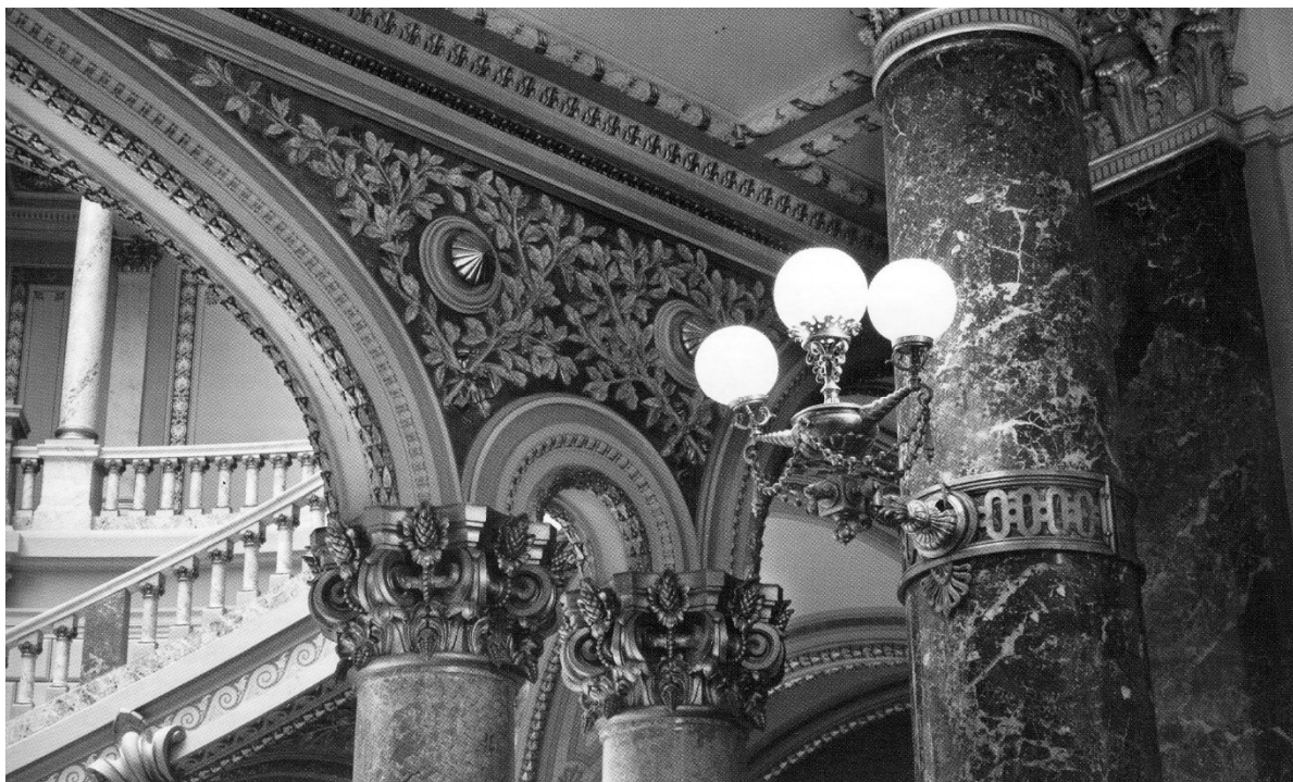
Detaliul coloanelor de susținere a peretelui ce desparte scena de noua construcție (pg. 119 - Nicolae St.Noica - ATENEUL ROMÂN ȘI CONSTRUCTORII SĂI)
