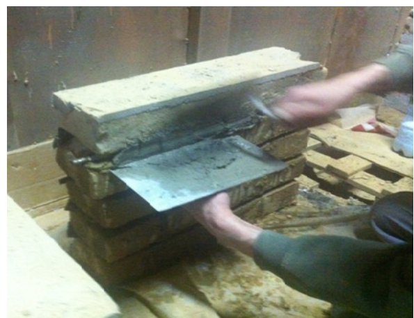
Fig.5 - Dispunerea corzilor din fibre și refacerea rosturilor prin umplere cu noul tip de mortar/ Fibre chords placement repointing the rehabilitated joints with the new mortars .
