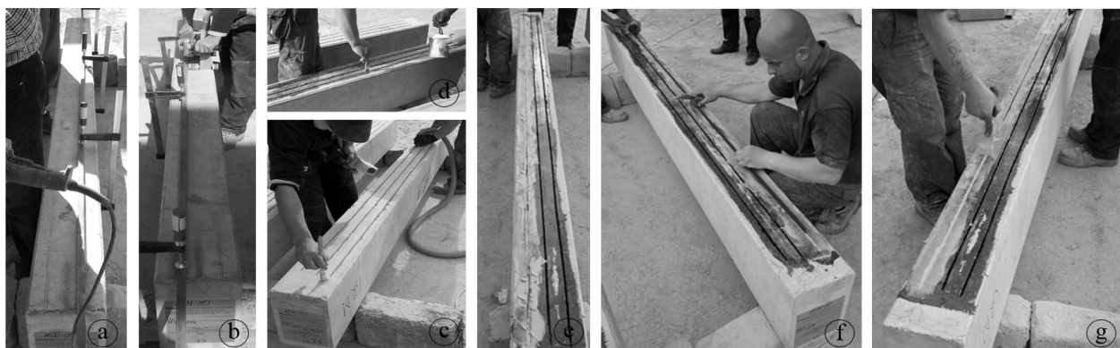
Fig. 6 - Prepararea șlițurilor / Slits preparation: a) trasarea pozițiilor șlițurilor / marking the grooves position; b) tăierea șlițurilor / saw-cutting the slits; c) curățarea șlițurilor / cleaning the grooves; d) aplicarea grundului / applying the primer; montarea fâșiilor din CPAFC în șlițuri / inserting the CFRP strips into the cut grooves; e) aplicarea adezivului / applying the adhesive; f) montarea fâșiilor din CPAFC / mounting the CFRP strips; g) înlăturarea excesului de adeziv / removing the excess epoxy adhesive.
