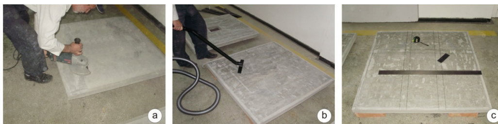
Fig. 2 - Pregătirea suprafeței: a) îndepărtarea laptelui de ciment și a substanțelor de decofrare; b) aspirarea prafului; c) marcarea pozițiilor platbandelor CPAFC / Surface preparation: a) removing cement laitance and traces of form-release oil; b) vacuum dust removing; c) marking the CFRP strips position.
