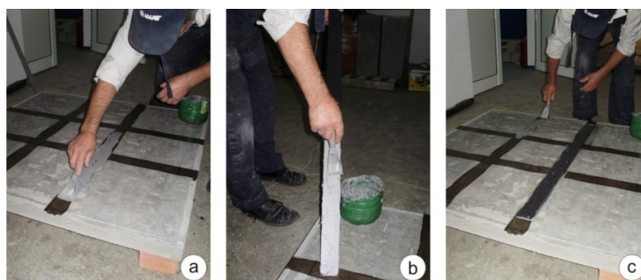
Fig. 3 - Aplicarea platbandelor CPAFC pe placa din beton armat: a) aplicarea adezivului pe placă; b) aplicarea adezivului pe platbanda CPAFC; c) aplicarea platbandei CPAFC pe placa din beton armat / Applying the CFRP strips on RC slab: a) applying the adhesive on the RC slab; b) applying adhesive on the CFRP strip; c) applying the CFRP strip on the RC slab.
