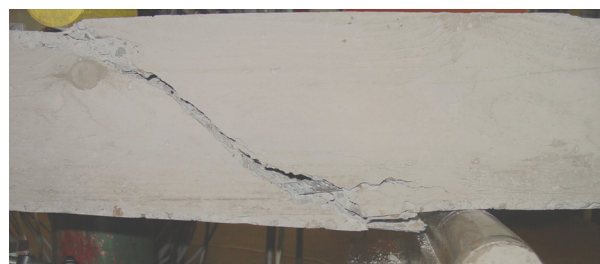
Fig. 7 - Fisura din forfecare la grinda consolidată cu platbandă din CPAFC / Shear crack of the CFRP strengthened beam.
