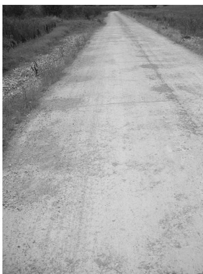
Fig. 2 - Pilot road constructed with high volume of fly ash and limestone aggregates / Construcție pilot a drumului, cu beton cu volum mare de cenușă și agregat calcaros.
