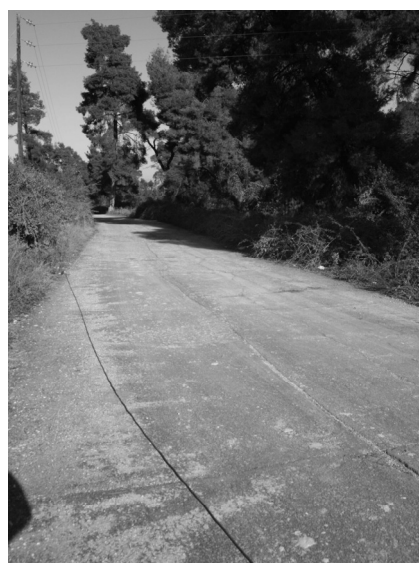
Fig. 3 - Pilot road constructed with high volume of fly ash and steel slag aggregates / Construcție pilot a drumului, cu beton cu volum mare de cenușă și agregat constând din zgură de oțelărie.
