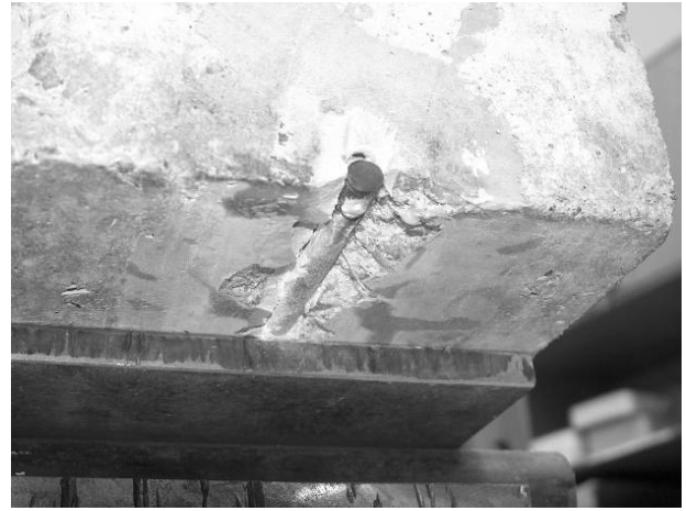
Fig. 16 - Slipping of the CFRP reinforcement due to the loss of bond at the joint with the epoxy resin / Alunecarea armăturii din CFRP datorită pierderii conlucrării cu rășina epoxi.
