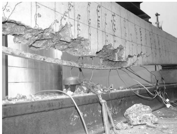
Fig. 17- Separation of concrete at the height of the concrete cover and crack distribution (front side of the beam) / Separarea betonului pe înălțimea stratului de acoperire cu beton a armăturii și distribuția fisurilor (pe partea din față a grinzii).
