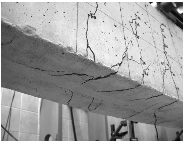
Fig. 13 - Beam failure resulting from the loss of concrete-epoxy joint / Cedarea grinzii datorată pierderii conlucrării între beton și epoxi.
