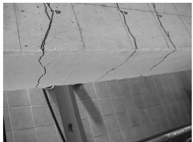
Fig. 20 - Typical cracks in the zone of pure bending on the tensioned (lower) side of the control beam after the bearing capacity is exhausted / Distribuția fisurilor pe fața inferioară a grinzii în momentul atingerii capacității portanței a grinzii.
