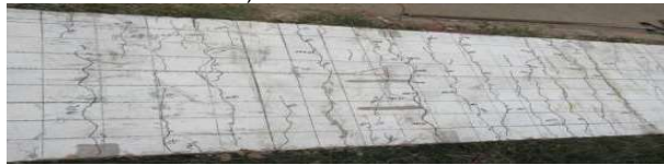
e) DHB-3 bottom crack
