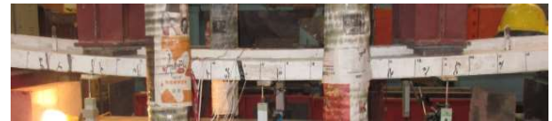
a) YDB-1 side crack
