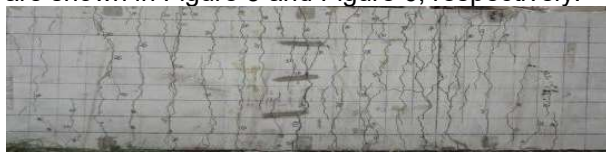
a) DHB-1 bottom crack
